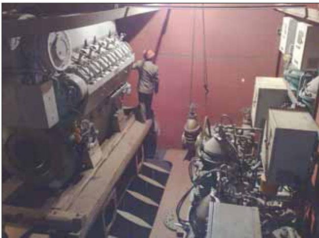
Рис. 11. Установка главного двигателя на судно
