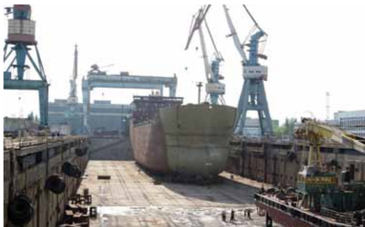
Завод «Залив», размеры дока (LxВxН) 354x60x13 м
