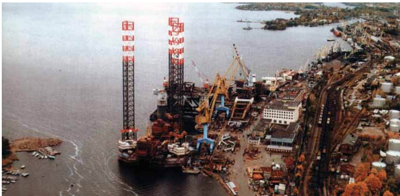
Достроечная набережная для буровых платформ, Выборский судостроительный завод
